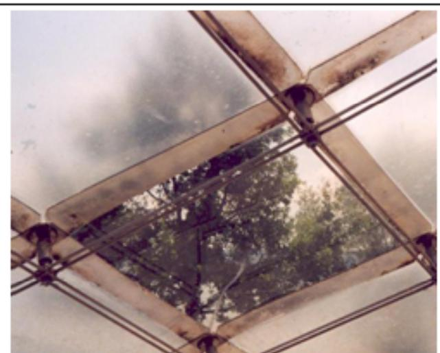
**Bild 1.10** Konzertsegel Radolfzell: Der Unterschied zwischen den alten, blinden Schindeln und der frisch Ausgewechselten ist gut zu erkennen
