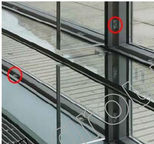
Für diese Verklebung kommt dabei ein handelsüblicher „Structural Glazing“ Klebstoff auf Silikonbasis mit der Bezeichnung DC 993 der Firma „Dow Corning“ zum Einsatz, der sich durch seine hervorragenden mechanischen Eigenschaften auszeichnet.
