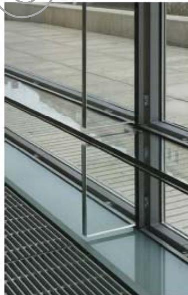
Da die hierbei realisierte tragende Verklebung, von Glas und Stahl mit einem Silikonklebstoff innovativen Charakter aufweist, steht der Nachweis der Tragfähigkeit dieser Verklebung im Mittelpunkt aufwendiger experimenteller und theoretischer Untersuchungen.
